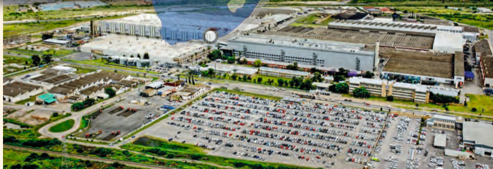
Blick aufs Werk: In Uitenhage arbeiten rund 4.000 Beschäftigte.
