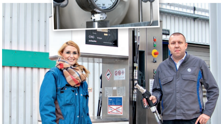
An der neuen Tankstelle: Daniela Paul, Planerin Versorgungstechnik, und Dariusz Gillner, Planer Befülltechnik und Projektleiter.
