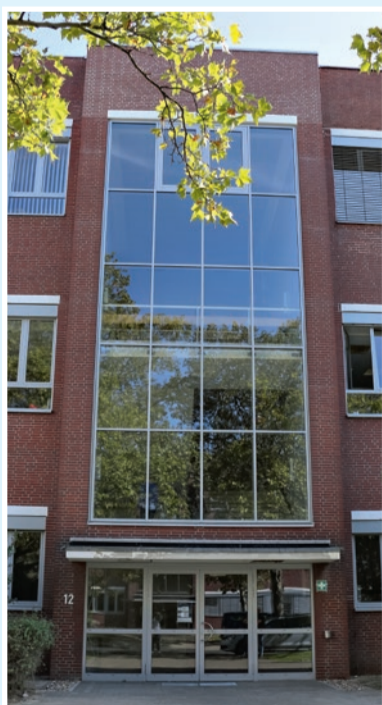
Sanierung: Die Fassade im Sektor 12 wurde renoviert.
