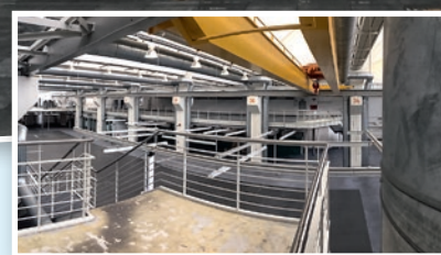
Vorher: Halle 6 im „Rohzustand“.
