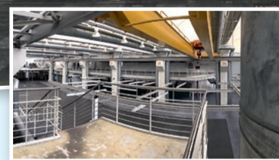
Vorher: Halle 6 im „Rohzustand“.
