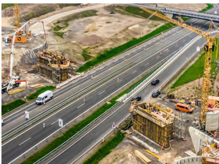
Die Bauarbeiten für die Fahrradbrücke sind in vollem Gange.
