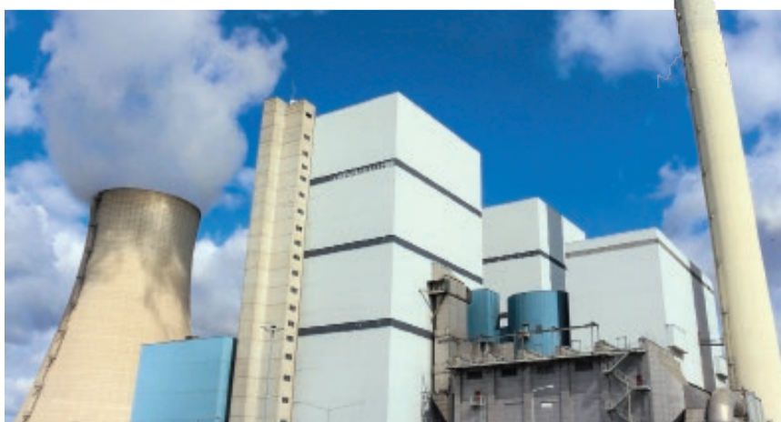
Heizkraftwerk West: Die Modernisierung kann beginnen.
