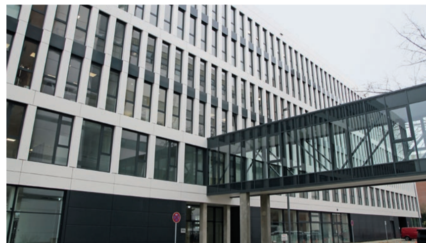
Außenansicht: Dank des Übergangs zum Konstruktionshochhaus sind die Wege kurz.
