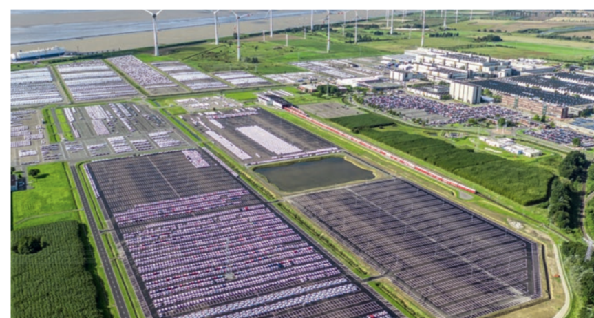
Blick auf das Werk Emden: Im Hintergrund sind Windkraftanlagen zu sehen.
