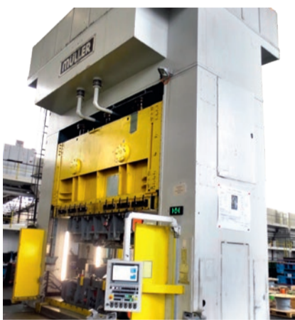
Im Presswerkzeugbau: die modernisierte Ziehpresse.
