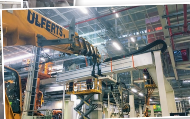
Karosseriebau, Aufbau: Auflegen des neuen, knapp fünf Tonnen schweren und verlängerten Kastenträgers.
