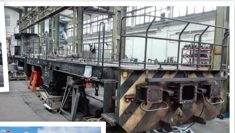
Vierachsige Altlokomotive: Sie wird bis auf den Rahmen abgebaut und ab dem Fahrwerk aufwärts komplett mit neuen Komponenten aufgebaut.
