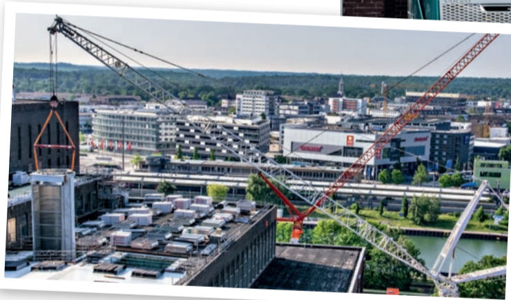
Präzisionsarbeit: Das Teil wird über eine Öffnung im Dach in das Kraftwerk eingelassen.
