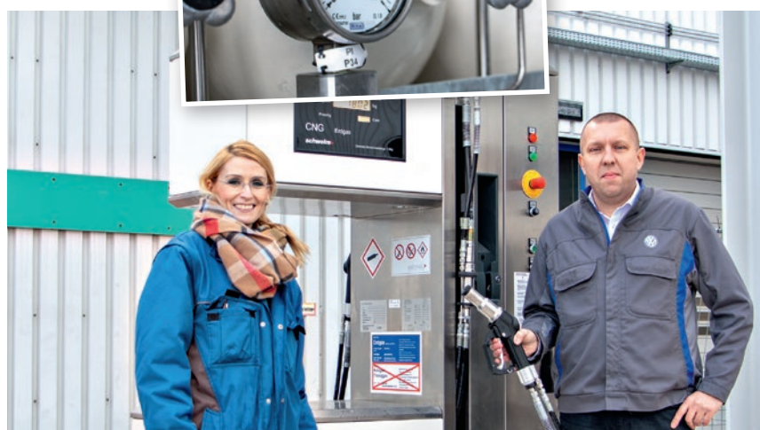
An der neuen Tankstelle: Daniela Paul, Planerin Versorgungstechnik, und Dariusz Gillner, Planer Befülltechnik und Projektleiter.
