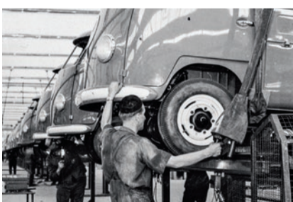
1956: T1 im Montagebereich Halle 1
