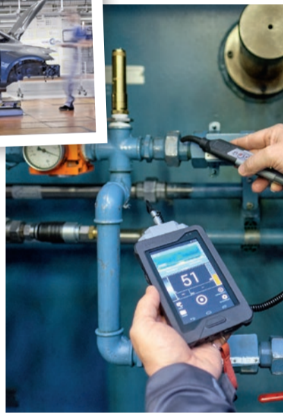
Prüfgerät im Einsatz: Das sogenannte Sonaphone hilft dabei, Druckluftlecks zu finden.
