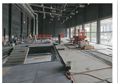
Großzügig: Bereits in der Bauphase ließen sich die Möglichkeiten des Foyers für Veranstaltungen erahnen.
