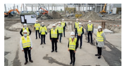
Gemeinsamer Besuch: Christian Vollmer besichtigte mit dem Werkmanagement und dem Betriebsrat die Baustelle.
