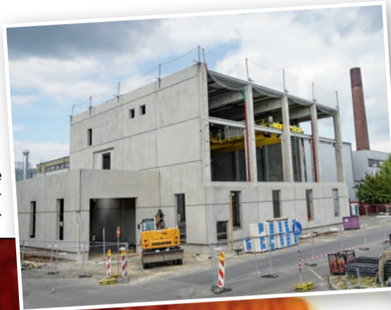
Im Rohbau: die neue Halle für die Späneschmelze.
