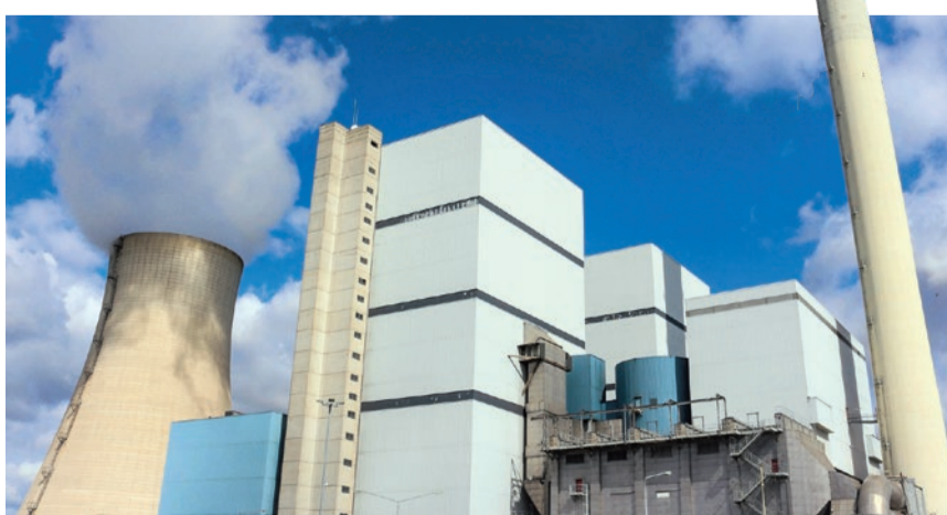
Heizkraftwerk West: Die Modernisierung kann beginnen.
