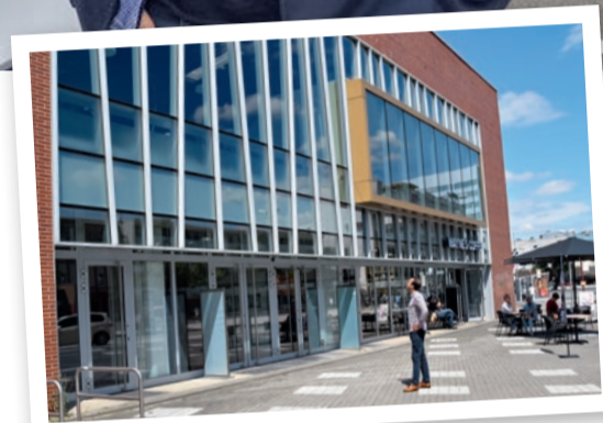
In der Markthalle: Hier findet der Unterricht künftig statt.
