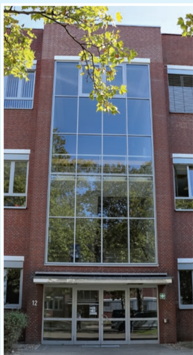
Sanierung: Die Fassade im Sektor 12 wurde renoviert.
