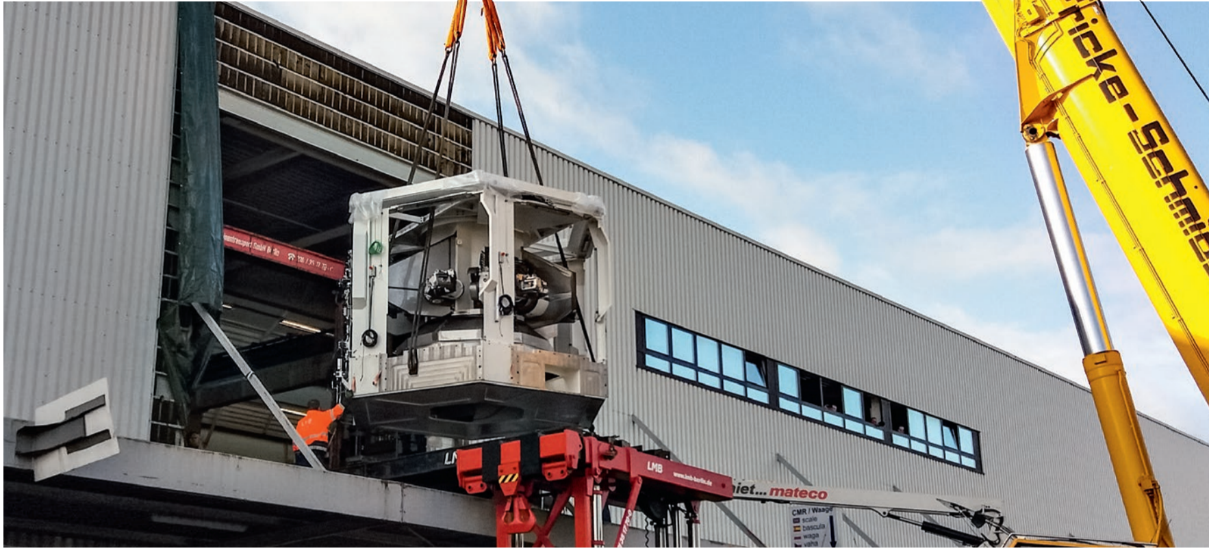
Millimeterarbeit: Der Schwerlastkran hebt das Mittelstück des Licon-Rundtischs in die Halle.
