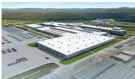
Erweiterungsbau für die Produktion der E-Autos im US-Werk Chattanooga
