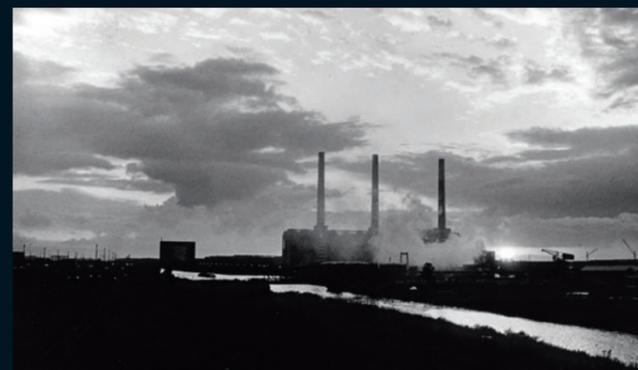
Gestern: Das in den späten 1930er Jahren gebaute Kraftwerk ist im Umbau. Im Norden kommt ein zweiter Heizblock dazu, der 1961 seinen Betrieb aufnimmt. Der dritte Schornstein steht schon, der vierte folgt 1965/1966.
